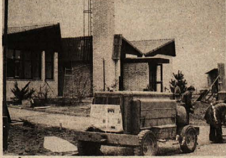
BO ŠE PRED NOVIM LETOM NARED? — V Bršljinu je novi vrtec brez večjih zastojev zrasel v nekaj mesecih, predvideno pa je, da bo ustanova začela poslovati še v letu 1978. Trenutno opravljajo v stavbi zadnja obrtniška dela. (Foto: R. Bačer)
