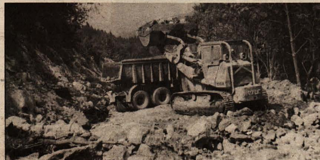
Na gradbišču odseka Stare žage
