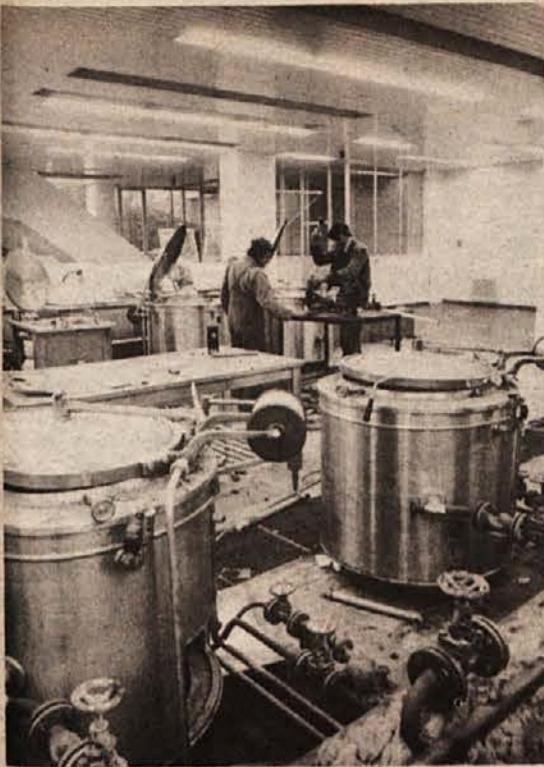
NOVA KUHINJA ZA BOLNIKE — Konec novembra bodo ob Šmihelski cesti odprli novo poslopje kuhinje in kotlarne bolnišnic in Zdravstvenega centra Novo mesto. V novih prostorih, ki so veljali 32 milijonov / din, bodo pripravljali 1200 obrokov hrane na dan. (Foto: Janez Pavlin)
