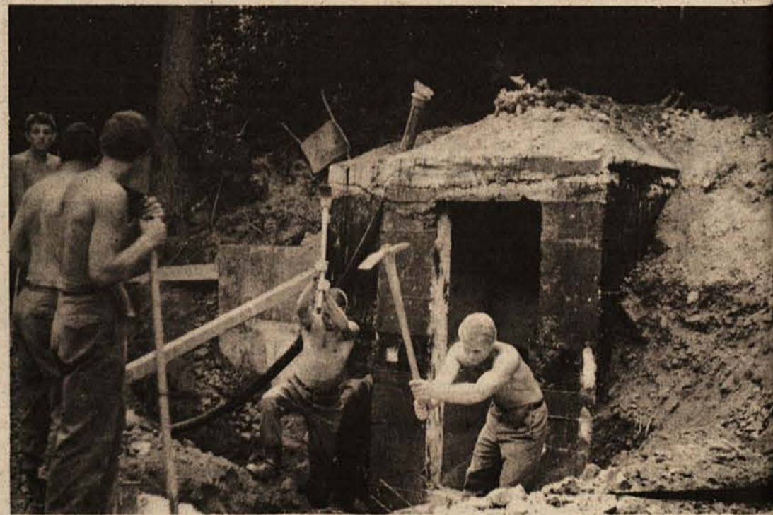
POTREBNI SO RAZTEŽILNIKI – Zaradi strmega padca vode so med zajetji in zbiralniki potrebni tudi raztežilniki, ki zmanjšujejo pritisk vode v cevih in preprečujejo, da bi se vodne napeljave po hišah prehitro kvarile. Na fotografiji: raztežilnik nad Osilnico.
