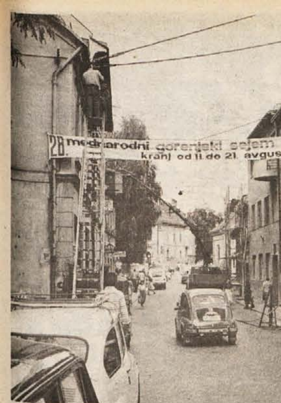
NOVA NAPELJAVA – Glavna ulica v Novem mestu je bila pretekli teden pravo mravljišče; ple-skarjem fasad so se pridružili še električarji, ki so zamenjali žice električne napeljave z modernejšimi kablji. Napeljavo bodo obnovili v vsem mestu. (Foto: M. Markelj)
