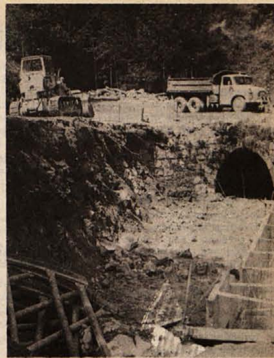
MAKADAMA VSE MANJ – Partizanska magistrala, ki bo skrajšala pot Belokranjcem do Ljubljane, bo nared novembra. Eno večjih gradbenih ovir premagujejo delavci ta čas na novomeški strani. Delajo tik pod jezom, ki je od Črmošnjic oddaljen le nekaj kilometrov. (Foto: P. J.)
