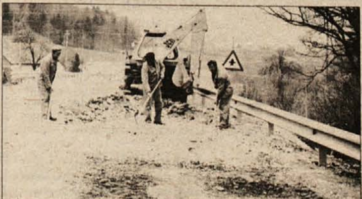
POPRAVLJANJE NAPAK - Delavci Cestnega podjetja Novo mesto so se vnovič lotili odseka ceste Novo mesto - Dolenjske Toplice pri Srebrničah. Iz neuradnih virov se je zvedelo, da bo odsek nared junija, kar je (samo) leto dni zamude. (Foto: J. Pavlin)
