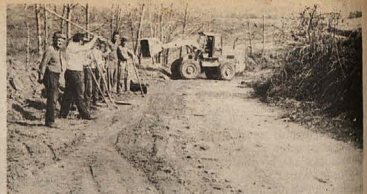
S SVOJIM DELOM IN DENARJEM — Vaščani Prilozja so se odločili, da bodo 1.800 m dolgo zelo slabo vaško pot popravili in uredili za asfaltiranje. Sedem vaščanov je zbralo 100 tisočakov, prav tako bodo vaščani sami opravili vsa zemeljska dela. (Foto: J. Kapušin)
