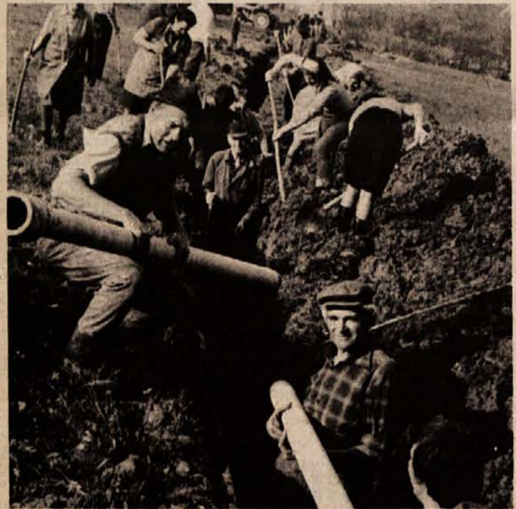
NAPORNO DELO V JARKIH – Del Dolenje vasi in Arnevega sela bo dobilo vodovod. Do zdrave pitne vode se bodo prebivalci dokopali s trdim delom. Pridne roke bodo premagale vse ovire. Vodo bo dobilo 41 gospodinjstev. (Foto: Zupancič)
