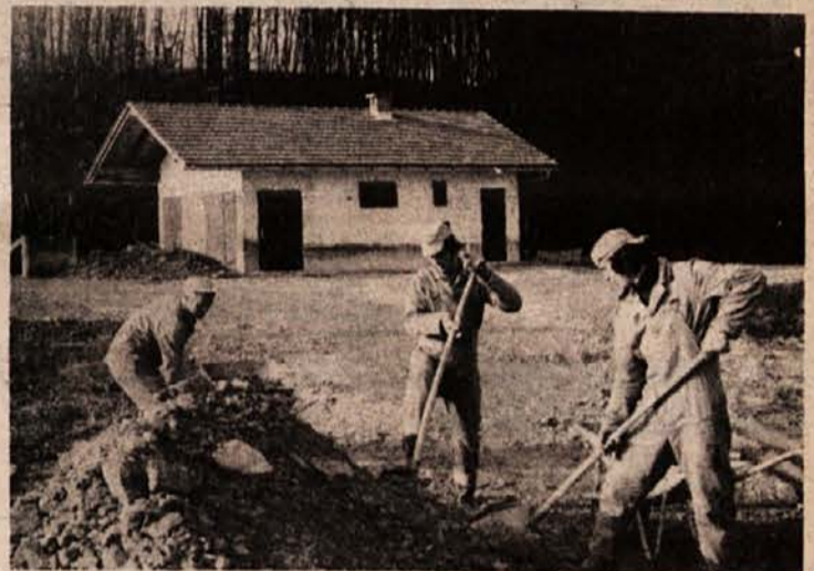
ŠE ENA PRIDOBITEV - Odkupna postaja in zbiralnica mleka v Trebnjem ne sodita skupaj. Kmetijska zadruga je zato zgradila primeren objekt ob cesti proti Mirni. Minuli teden so poskrbeli za okolico.
