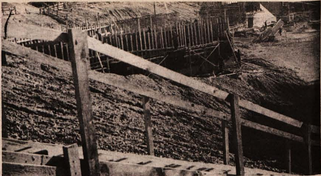
JEZ NA SAVI — Gradijo ga ob jedrski elektrani v Krškem, da bodo imeli vse leto dovolj vode za hlajenje reaktorja in da v času majhnega pretoka ne bi segreli reke nad dovoljeno mejo. (Foto: Jožica Teppey)
