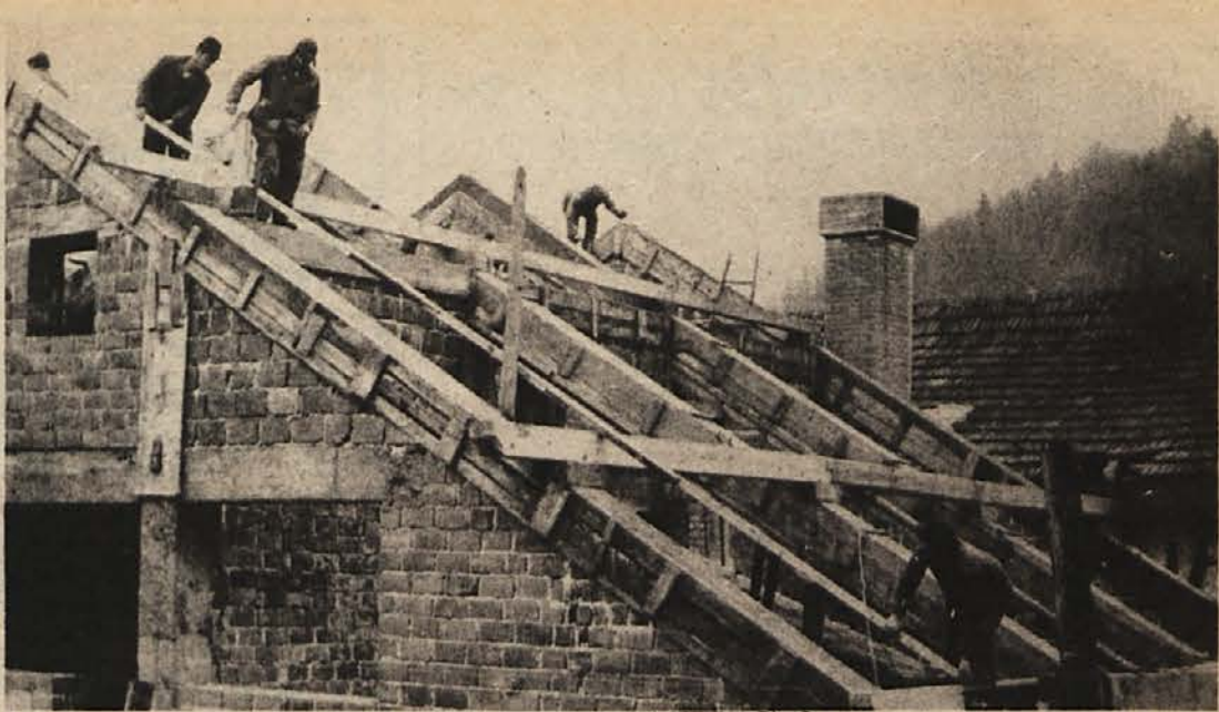
LEP PRIZIDEK – Novi prizidek pri miremskem domu TVD Partizan – s ceste ga zakriva stari dom – je velik objekt. Skupaj z domom bo postal res pravo kulturno središče kraja. Minuli teden so delavci Dane, IMV in Kolinske namesčali ostrije. (Foto: Železnik)
