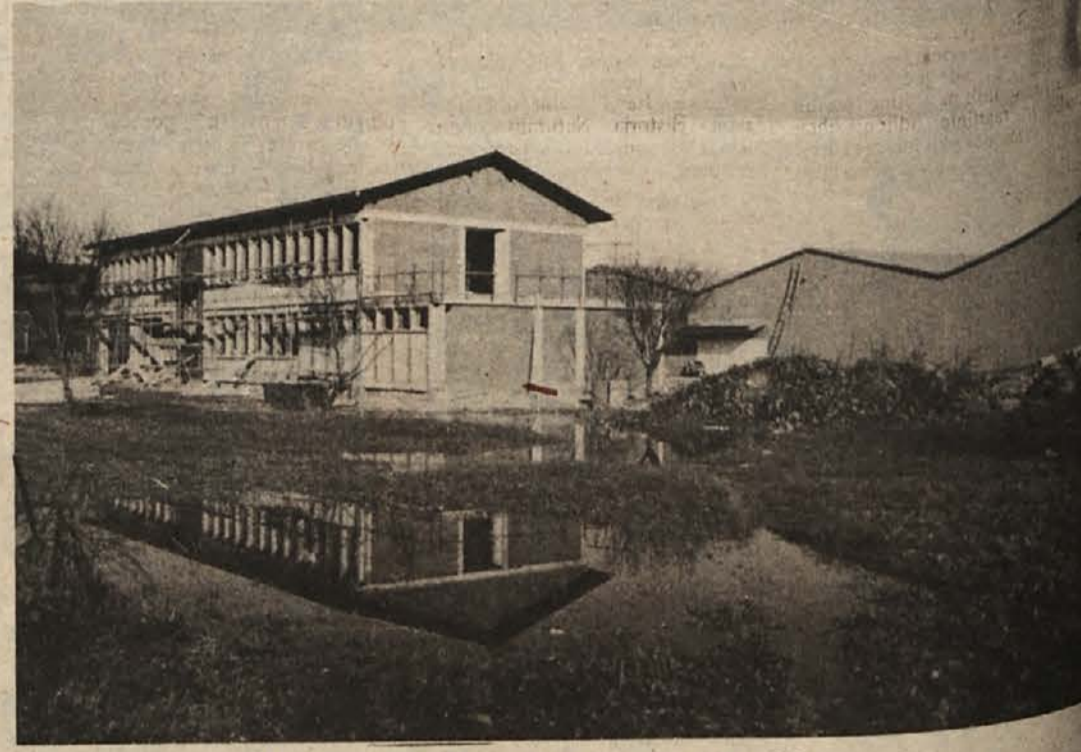
Upravna stavba „Komet“ v zaključni fazi izgradnje.
