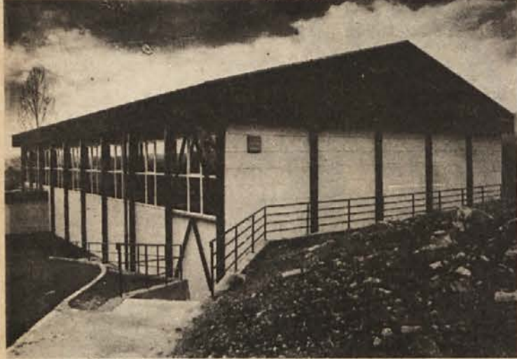
Športna dvorana v Metliki je zgrajena.
