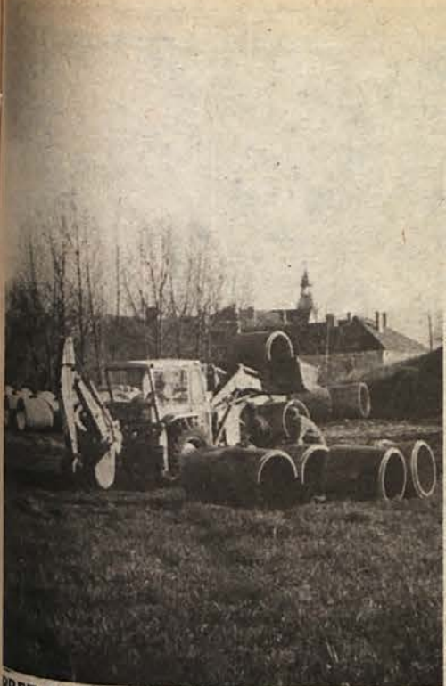
BREZ TEGA NE GRE – Novograd in Vodna skupnost gradita v Šmihelu kanal, ki bo odrešil tri nove šolske objekte odvečnih skrbi. Jašek, ki je globok tudi do 5 m, bo potekal do razbremenilnika nad potokom Težka voda. Kasneje bodo kanal priključili na novomeško čistilno napravo. (Foto: M. Markelj)
