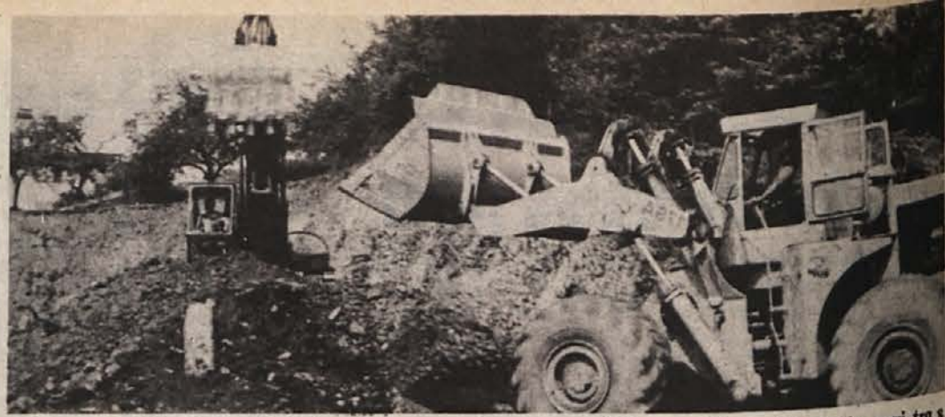
IZKOP ZA BANKO. Stroji rijejo v hrib nasproti samopostrežnice na Vidmu, kjer bodo novi trg s spomenikom Matiji Gubcu zaključili s poslovno zgradbo posavske banke. (Foto: J. Teppey)
