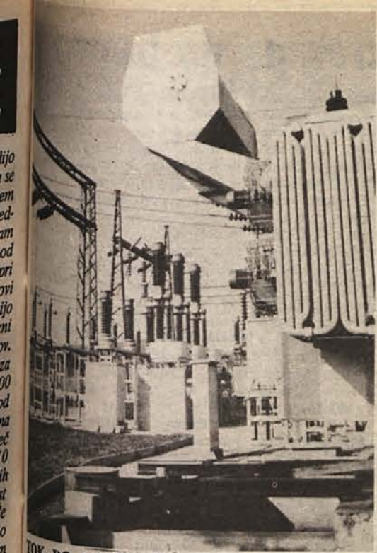
TOK BO MOČNEJŠI – Delavci novomeškega Elektra so v noči med 29. in 30. oktobrom za dobri dve uri izključili električni tok skoraj za vso Dolenjsko. To so naredili zato, da so lahko stari transformator zamenjali z novim, ki ima za 11,5 MVA večjo moč. Kmalu bo tudi v Novem mestu boljši tok. (Foto: J. Pavlin)
