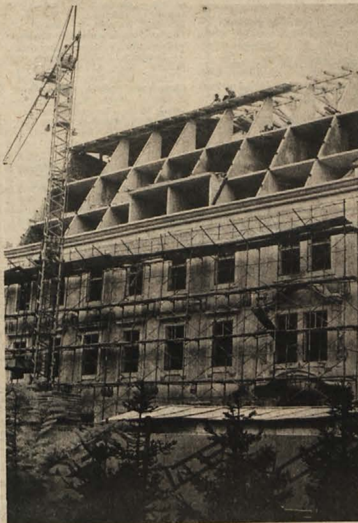
NOVO NA STARO — V Dol. Toplicah je nadgradnja zdraviliškega doma predmet radovednežev, ker gre za nenavadno obliko, krajani pa komaj čakajo, da bo dom lahko sprejel goste. (Foto: R. Bačer)
