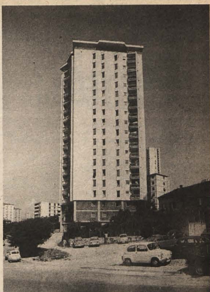
Stanovanjska stolpnica na Reki (TOZD Reka)
