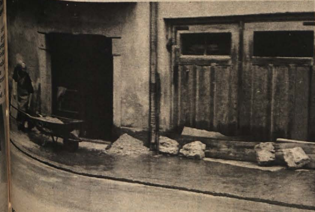
PROPLAVljena RIBNICA – V noči z nedelje na ponedeljek je Ribnico za okoli 4 ure zalila voda in povzročila veliko škodo, ki jo še ocenjujejo. Enote CZ (predvsem gasilci) in vsi občani so zavzeto sanirali posledice poplave, ki je napravila v Ribnici največ škode Žičnici in zasebnim hišam. Več na zadnji strani. (Foto: Primc)
