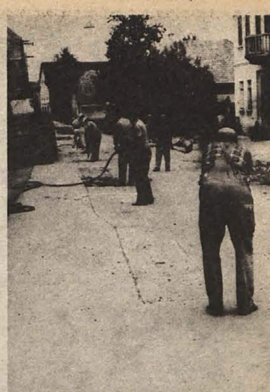
POKRPANE LUKNJE – Do nedavnega je bila voznja skozi Dolenjo vas pri Ribnici močno neprijetna in nevarna, zakaj minula zima in gost promet sta cesto doobara zdelali. Zato se je krajevna skupnost odločila za temeljito popravilo in nevaren cikcak med luknjami ni več potreben. (Foto: J. Pezelj)
