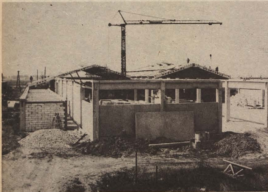
GRADNJA MONTAŽNE HALE „TOGREL“ S STREHO NOVEGA TIPA — DVOKAPNICO — V VELIKI GORICI PRI ZAGREBU
