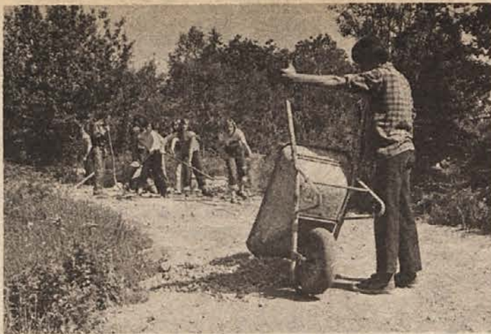
USPELA AKCIJA – Mladinci, krajanji in vojniki so v soboto dopoldan temeljito popravili nad 10 km makadamskih cest v KS Bircna vas. Na sliki: najtežje je bilo na novozgrajeni cesti Podljuben–Gornje Mraševo. (Foto: Janez Pavlin)
