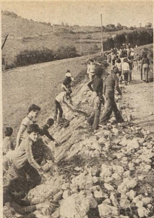
HITREJE DO CESTE – Vaščani KS Težka voda in Podgrad si prizadevajo, da bo nova cesta z Dolza do ceste čez Gorjance čimprej nared. V torek popoldan je nad 250 pionirjev iz novomeške o.š. Grm odstranjevalo kamenje in pomagalo urejati teren bodoče ceste. Spodbudna delovna akcija. (Foto: Janez Pavlin)
