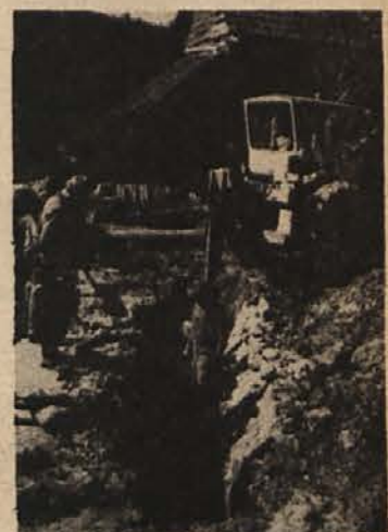
ZIVO NA TRASI — Podobnih prizorov kot je ta na sliki ob gradnji vodovoda v trebanjski Suhi krajini, letos ne bo manjkalo. Tokrat bodo poletni priskočili na pomoč tudi brigadirji.
