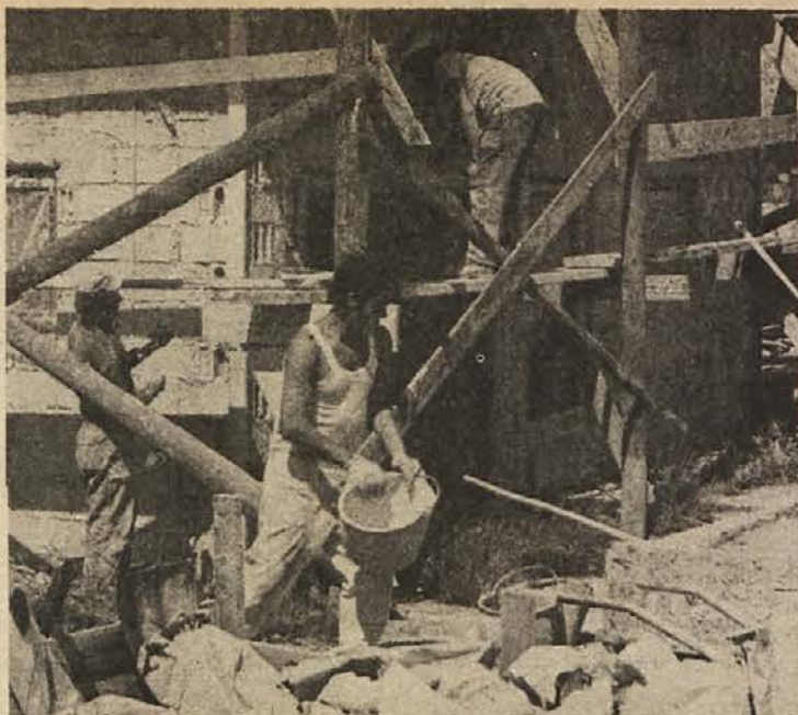
VREME ZA GRADITELJE – Črnomelj se je v toplih pomladnih dneh spremenil v veliko gradbišče. Ljudje porabijo vsako prsto urico, da bi bila hiša čim prej vseljiva, saj pomanjkanje stanovanj tare tudi Belokranjce.
