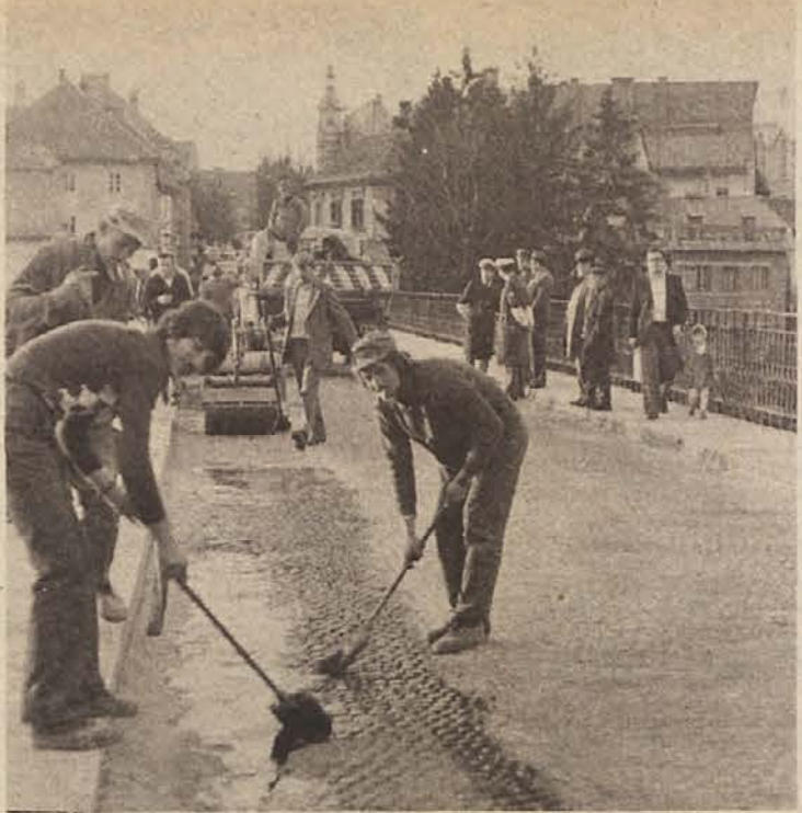
KRPANJE LUKENJ! – Pretekli četrtek je bil stari novomeški most popoldne zaprt za ves promet, ljudje pa so ugibali, zakaj. Nekaj ur zapore za promet (ne za pešce) so izkoristili za krpanje lukenj na gornjem sloju vozišča. (Foto: R. Bačer)
