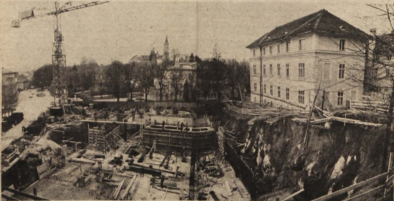
Pogled na eno izmed trenutno največjih gradbišč v Novem mestu: med poslopjem občinske skupščine in bencinsko črpalko pri osnovni šoli bo zrastle nova poslovna stavba podružnice Ljubljanske banke. Številni problemi v poslovanju z občani bodo omiljeni, ustvarjeni pa bodo tudi pogoji za nadaljnji razvoj bančne službe v občini in pokrajini. Na sliki: gradbena jama bodočega objekta. (Foto: Sandi Mikulan)
