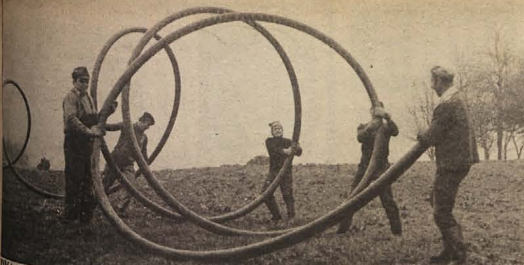
DVA VODOVODA — Letos bodo v krajevnih skupnostih Struge in Vimolj v kočevski občini izvedena glavna prizadevanja v gradnjo vodovodov. Oboji računajo tudi na pomoč mladine oz. mladinskih delovnih brigad. Na fotografiji: V Strugah so domačini že izkoristili lepe letošnje sobote za prostovoljno delo pri gradnji vodovoda. (Foto: Primc)
