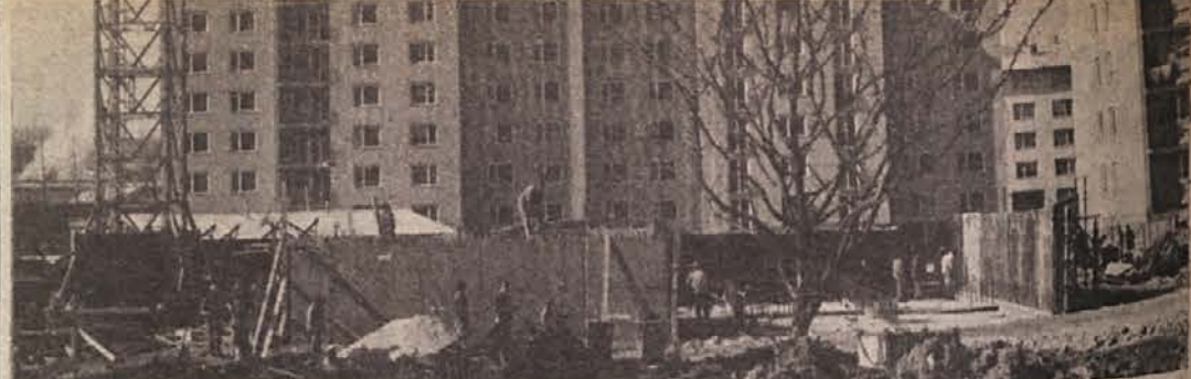
NOVO KRŠKO. Levi breg Krškega je letos eno samo gradbeno mravljišče. Na sliki novo stanovanjsko naselje, ki raste med železniško progo, cesto in bencinsko črpalko. (Foto: Jožica Teppey)
