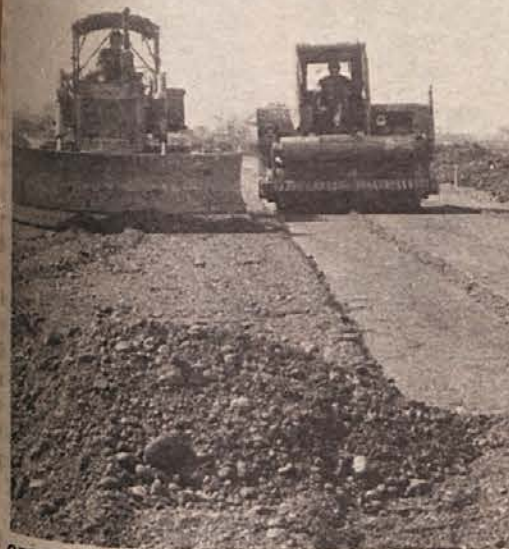
OBVOZNA CESTA – Mimo tovarne prikolic MV v Brežicah so začeli graditi cesto, ki bo razbremenila promet skozi mesto. Na križišču za Biželjso se bo obvoznica spojila s podaljškom Savskega mostu in priključkom na avtomobilsko cesto Ljubljana – Zagreb. (Foto: J. Teppey)
