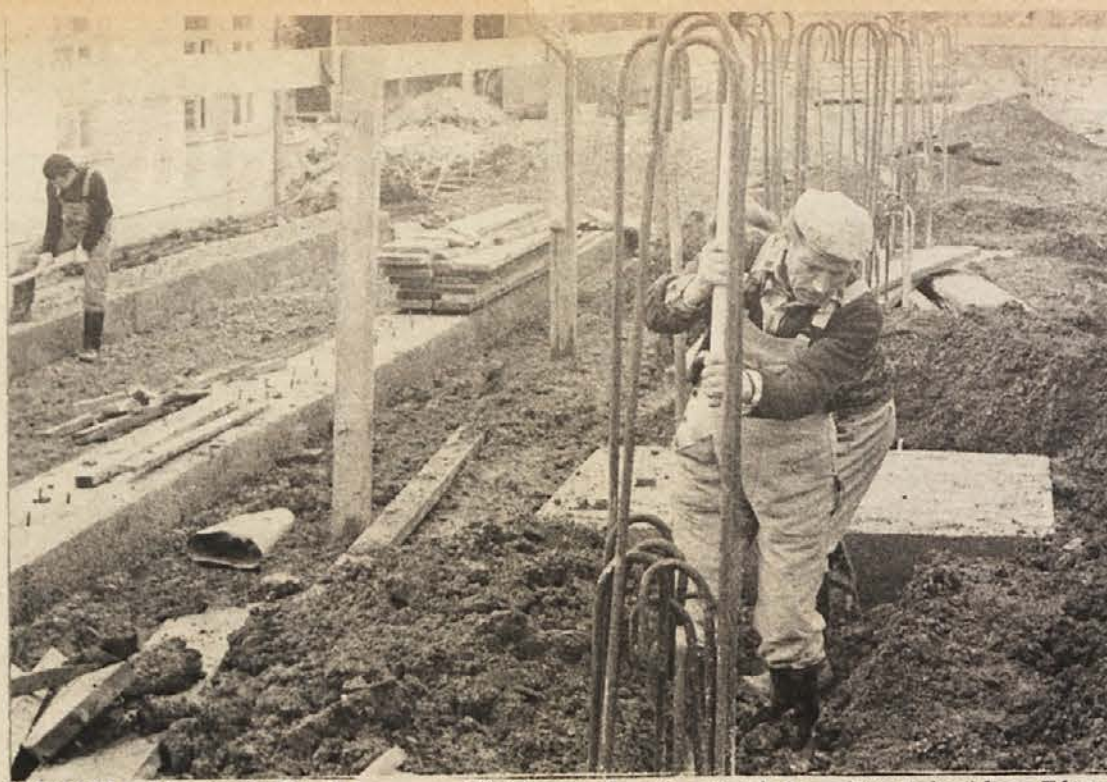
TEMELJI — Novomeški Pionir namerava kljub temu, da se je začetek dograditve trebanjskega Zdravstvenega doma pričel z zamudo, opraviti delo do poletja, kot so predvideli. Sama izvedba objekta omogoča hitro gradnjo.
