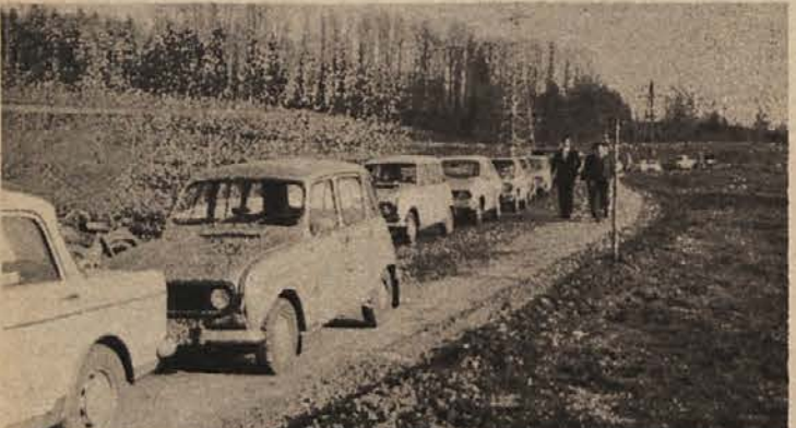
NOVA CESTA - Asfaltirana cesta Črnomelj-Sražnji vrh, ki so jo slovesno odprli v soboto, 27. novembra, je za občino velika pridobitev, še posebej pa so je veseli krajani KS Talčji vrh, saj bo sedaj tudi v njihove kraje lažje prišel napredek. Na sliki: dolga kolona avtomobilov je potem, ko je Jože Wolf prerezal trak, krenila proti Stražnjemu vrhu. (Foto: J. Pavlin)
