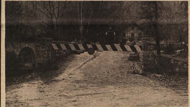
DOBIL KONČNO PODOBO - Delavci podjetja vodne skupnosti Sava iz Ljubljane so v teh dneh končali dela na obnovi starega kamnitega mostu v Ribnici. (Foto: D. Divjak)
