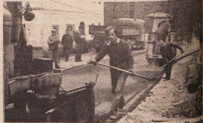
PREIZKUS ASFALTA – Pred kratkim je položila ekipa Slovenije ceste ob Kolpi pri vaseh Grintovec in Mirtoviči 300 m asfalta. Približno polovico asfalta (v vasi Grintovec) so položili na stari način, polovico (v Mirtovičih) pa so primešali neki dodatek. Tako preizkušata ljubljanski Zavod za raziskavo materiala in nemška firma, kateri asfalt se bo bolje obnesel. (Foto: Primc)
