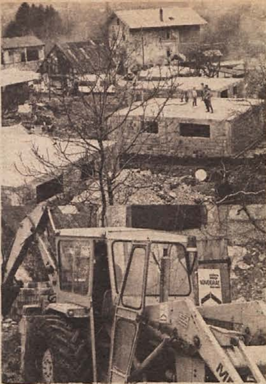
NOVOGRAD V POSOČJU – Ladra in Smast pri Kobaridu sta kraja, kjer pomagajo obnavljati prizadeto Posočje gradbinci novomeškega NOVOGRADA. Od začetka oktobra je na gradbišču povprečno 25 delavcev z vsa potrebno mehanizacijo, doslej je zgradili 9 objektov do prve plošče. V Drežniških Ravnah na pobočju Krna pa so te dni začeli obnavljati več poslopj.
