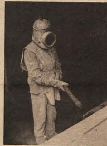
S peskanjem jeklenih površin dosežejo lahko visok sijaj.
