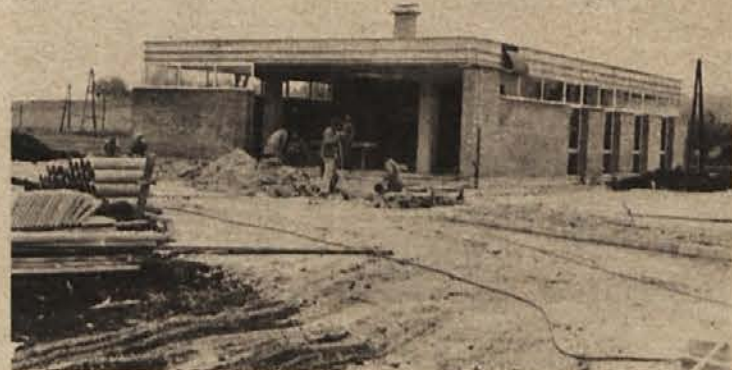
Gradbišče agencije Ljubljanske banke v Ivančni gorici
