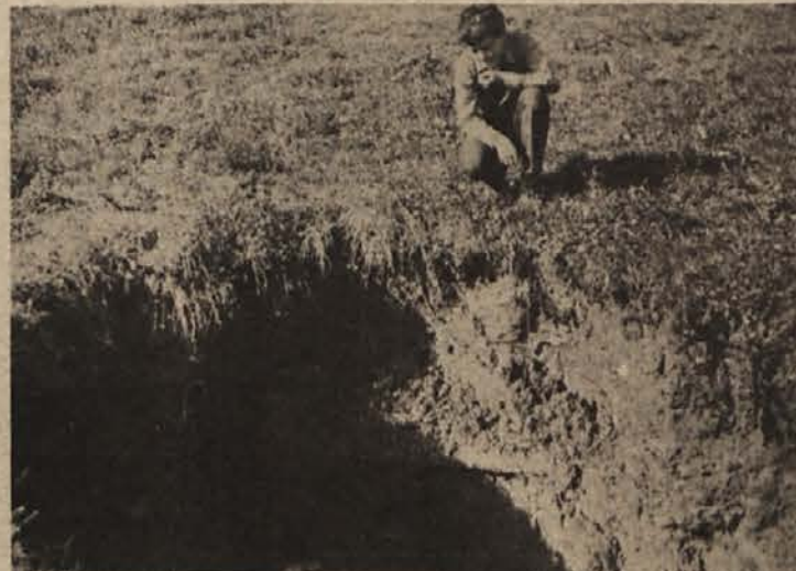
VELIKA LUKNJA SREDI SEMICA – 21. oktobra ponoči se je sredi Semiča na zelenici pred pošto vdrla zemlja, tako da je nastala jama v premeru 4 – 5 metrov in 3 metre globoka. Prav na tem mestu je speljana kanalizacijska cev, ki se je prelomila in sedaj odpadne vode odteka v globino zemlje. (Foto: Marko Klinec)
