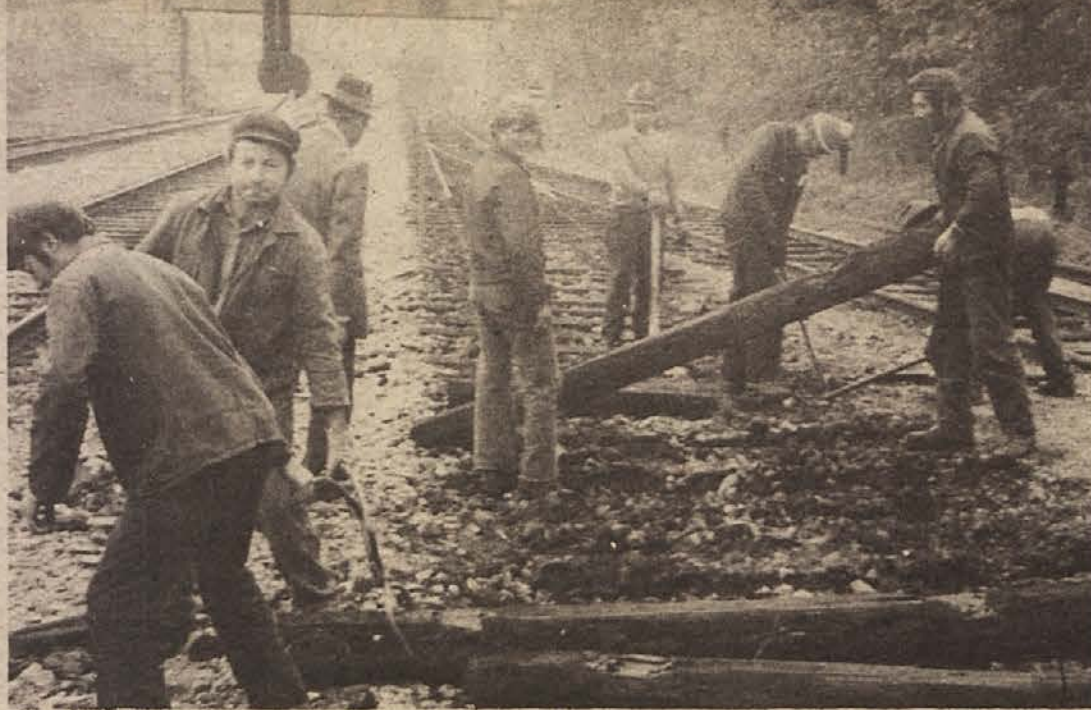
KMALU PERON? Na trebanjski železniški postaji je potrebno obnoviti dotrajane ture. V kolikor bo vreme ugodno, bodo železniški delavci med tiri uredili tudi peron. Na sliki: staro daje mesto novemu. (Foto: Železnik)
