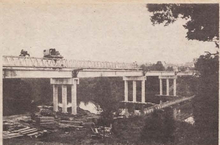
Gradnja mostu čez Krko
