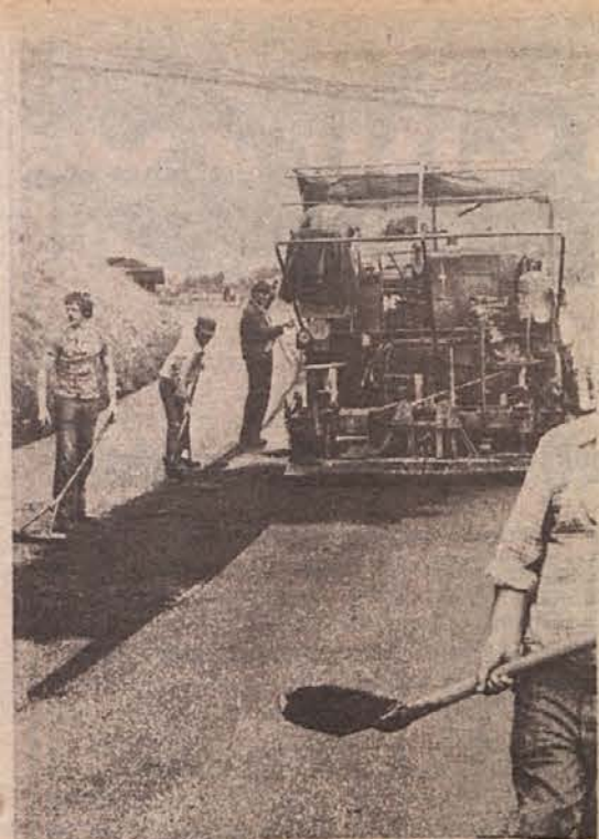
SPET GLADKA CESTA — V okviru rednega vzdrževanja so delavci novomeškega Cestnega podjetja položili novo asfaltno površinsko prevleko na okoli dva kilometra dolgem odseku ceste od Gornjega Polja do prehoda čez železniško progo v Straži. Dela pri asfaltiranju so končali v ponedeljek. (Foto: Bartelj)
