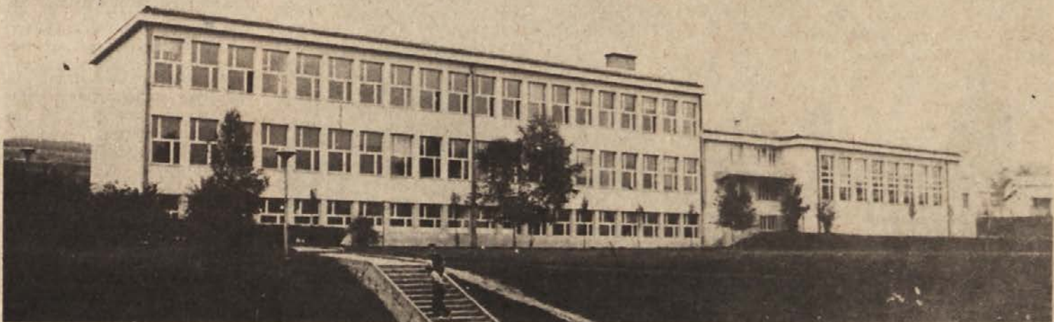
Nove šole, povečani zdravstveni domovi, otroški vrtci in urejena preskrba krajev sodijo med naloge, ki jih v okviru srednjeročnega razvojnega načrta zajemajo sporazumi o razvoju družbenih dejavnosti v regiji. Na sliki: pogled na trebanjsko osnovno šolo s telovadnico. Urejeno okolje že v mladini privzgaja čut za čistost in lepoto naših bivališč
