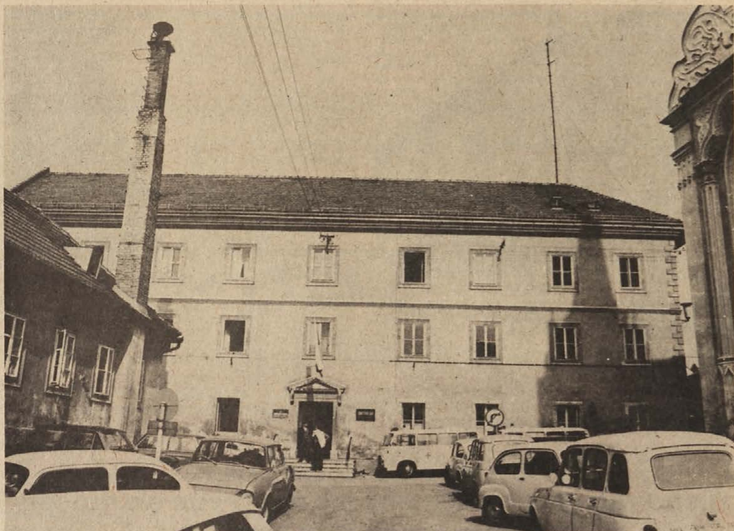
V več kot 230 let stari prvi zgradbi novomeške gimnazije, kasnejši kasarni in za druge namene uporabljeni upravni stavbi v današnji Jenkovi ulici v Novem mestu deluje novomeški zdravstveni dom, ki že davno ne ustreza več zahtevam sodobnega zdravstva. Zeleno luč mu prinaša srednjeročni načrt razvoja: v letih 1977-1979 naj bi zgradili novega
