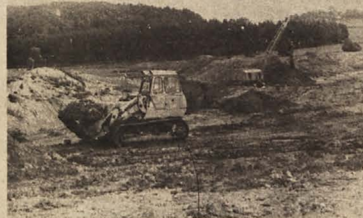
Glinišče – delo pri izkopu surovine, kjer so zaloge za 300 let
