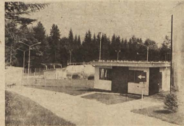
Plinska in vodovodna postaja
