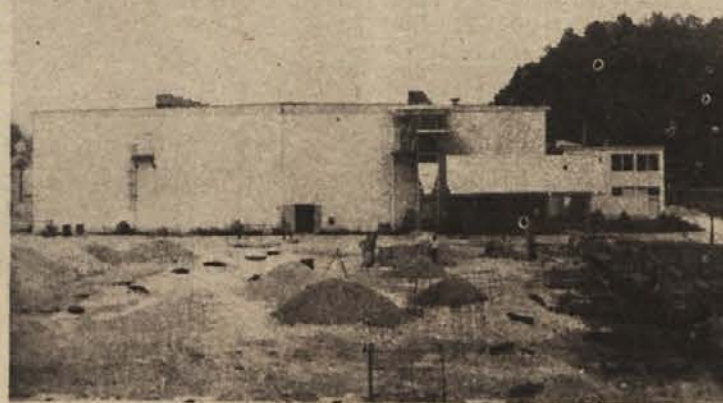
Ob tovarni na Mirni bo iz temeljev kmalu zraslo novo skladišče.
