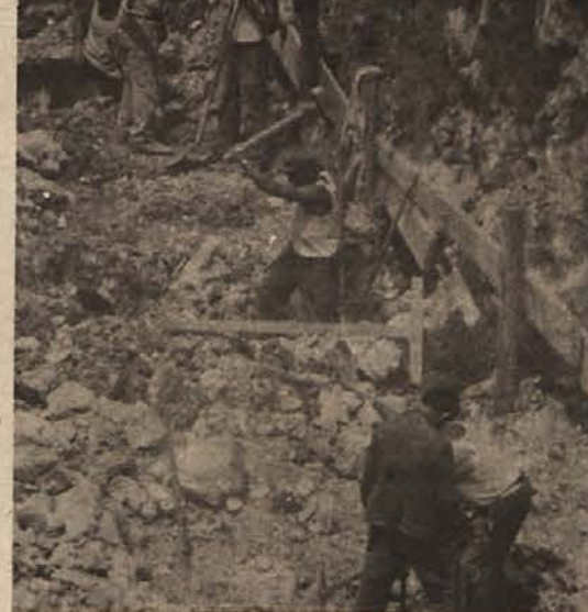
TEMELJI ZA ŠPORT – Za metliško osnovno šolo so se delavci te dni spopadli z dokaj težkim terenom, navzlic temu pa so temelji za novo metliško športno dvorano skorajda pripravljeni. Na sliki: delavci pri kopanju temeljev. (Foto: Janez Pezelj)
