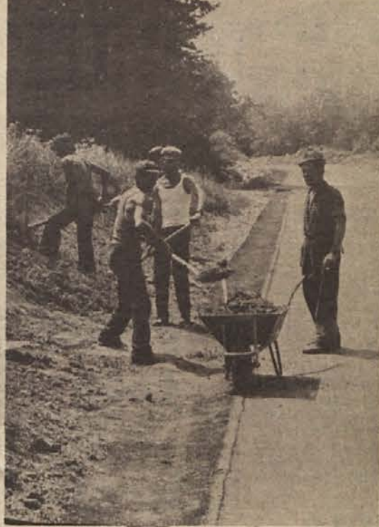
RUDARJI NA CESTI – Pred kratkim je začelo novomeško Cestno podjetje urejati okolico ceste Črnomelj-Adlešiči. Pri teh delih so zaposleni v glavnem kanizarski rudarji. Čeprav delo v primerjavi z rudarskim ni težko, si žele kmalu vrniti se v jama. (Foto: A. Bartelj)
