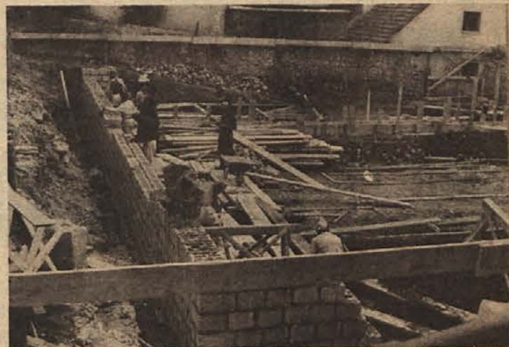
ZAČNE SE PRI TEMELJIH... - konča pa pri strehi! Tako je pri vsaki stanovanjski gradnji. Tudi na Drski v Novem mestu, v Šentjerneju in Žužemberku, kjer so že določene cene za kvadratni meter stanovanjske površine v blokih in vrstnih hišah.
