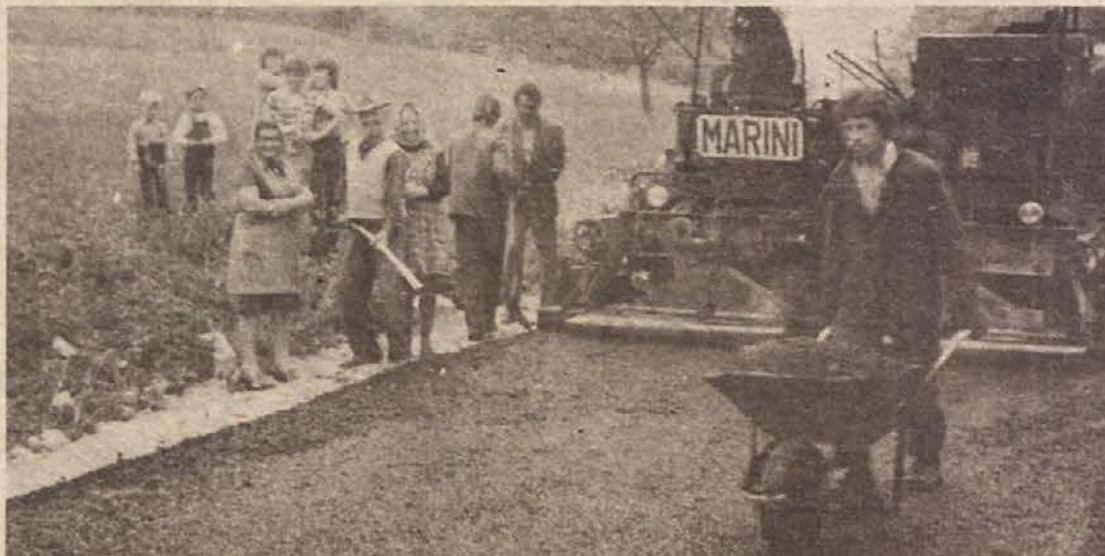
Te dni dobivajo spet asfalt nekatere ceste v ribniški občini, med njimi zadnji odsek 2,7 km dolge ceste Jurjevica-Breže-Kot, katere asfaltiranje bo veljalo nad 2 milijona dinarjev. (Foto: Primc)
