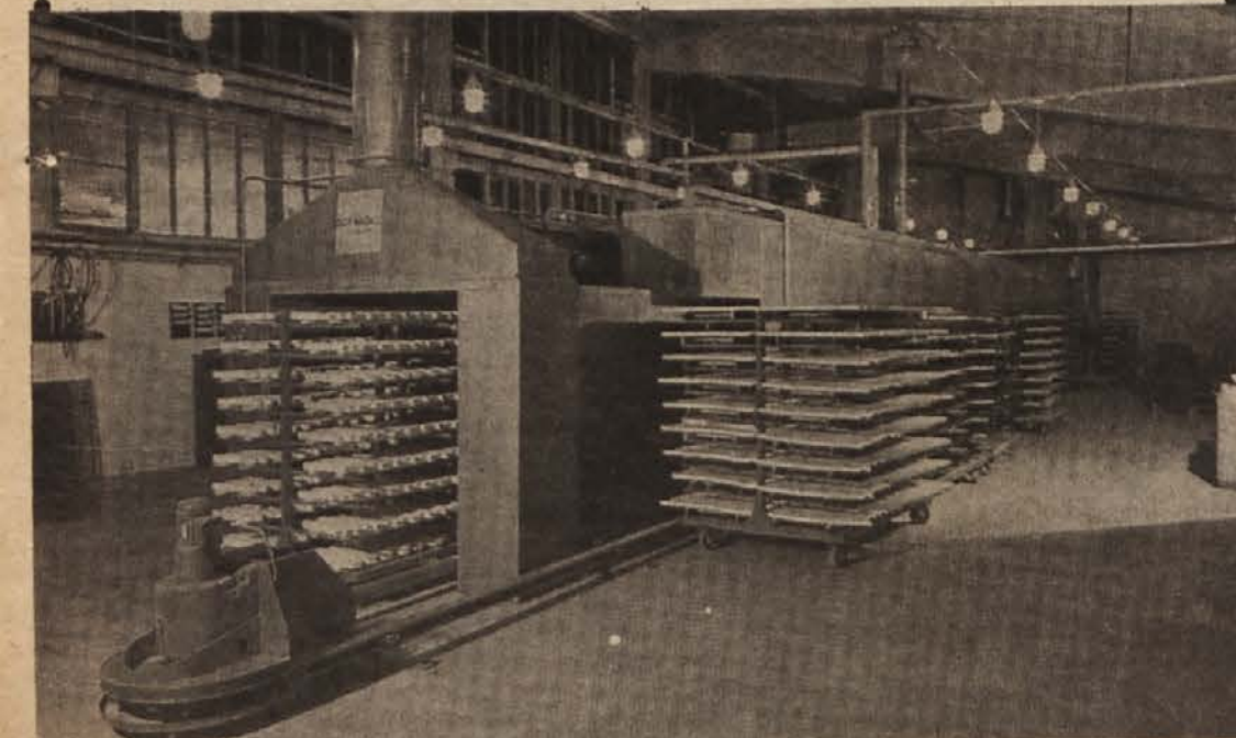
Za lakiranje in sušenje uporablja lesna industrija lakirnice in sušilnice, ki jih izdelujejo v „SOP“ Krško. Na sliki je lakirnica v Novolesu v Straži.
