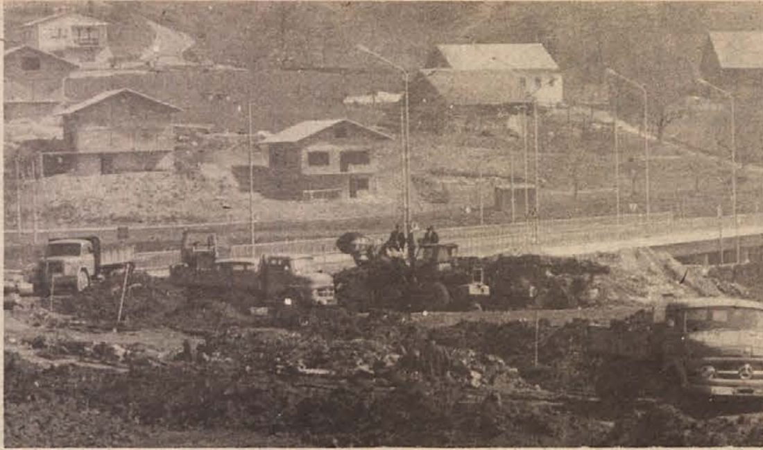
LAŽJE NA MOST – Občinska cestna služba gradi nov priključek na most čez Savo v Boštanju, kar že pomeni eno črno točko manj. Delo je medtem že toliko napredovalo, da se je po novem priključku že mogoče peljati.
