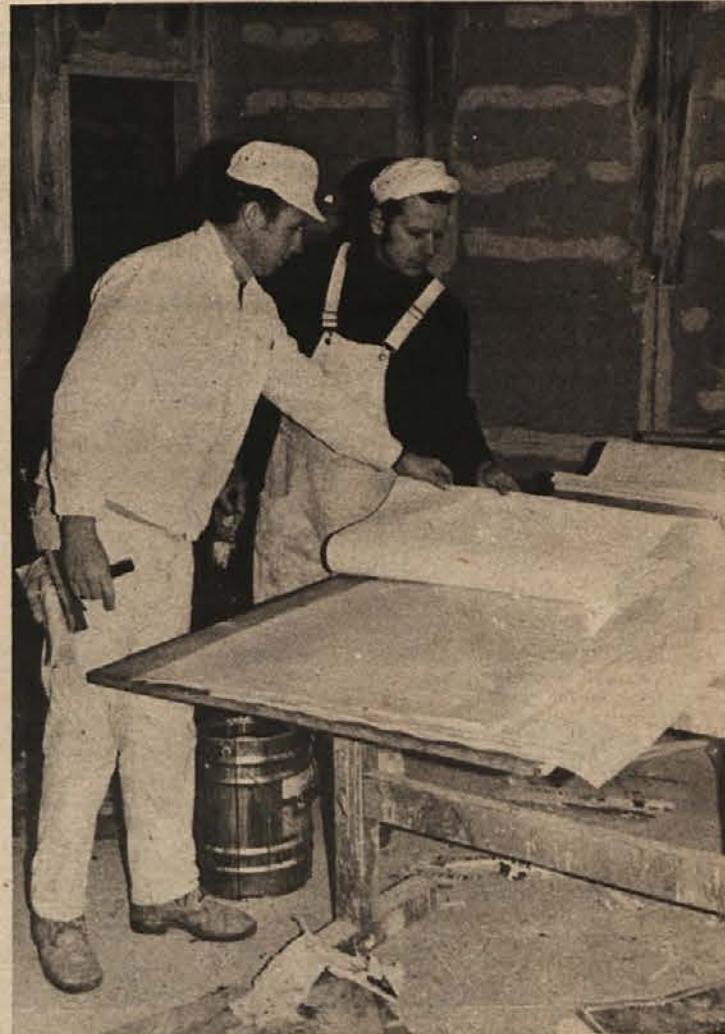
Nova Marlesova šola v Mokronogu naj bi bila nared do novega šolskega leta. Delo poteka zadovoljivo, tako da ni bojzani, da bi se gradnja zakasnila. V novi telovadnici so na delu pleskarji, v učilnicah pa že lepijo na stene tapete. (Foto: Železnik)
