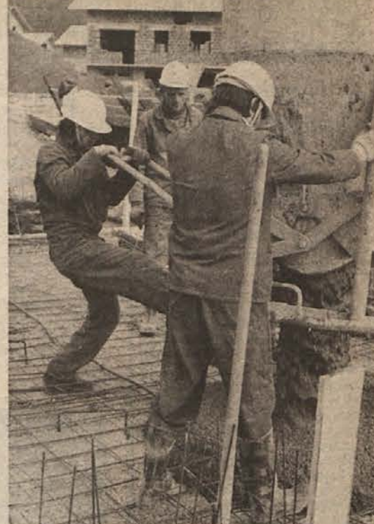
Gradbeniki SGP Grosuplje so v soboto v Trebnjem kljub mrazu vlivali ploščo na gradbišču drugega stanovanjskega bloka. Do novega leta bi radi izročili stanovalcem ključne novih stanovanj, na Pavlinovem hribu pa je še dosti stavbišč za nove bloke. (Foto: Železnik)
