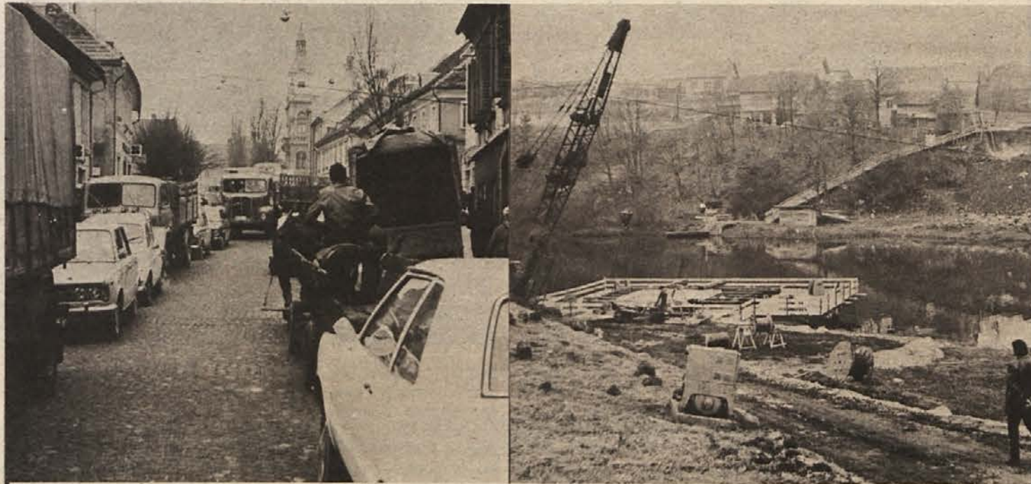
NOV MOST ŽE NASTAJA. Kako potreben je Novemu mestu nov most, zgovorno pričata posnetka, narejena isti dan ob istem času: 23. februarja ob 8.30. Prometna gneča pred vstopom na most in pa začetek gradnje novega mostu pri Ragovem. Dela za novi most so šele na začetku, upamo lahko le, da bodo hitro potekala. (Foto: Ria Bačer)
