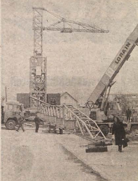
V Sevnici slednjič gradijo tudi novo pošto. Je zadnja v programu modernizacije pošt v občinskih središčih. Sedanji prostori v starem delu mesta so že popolnoma neustrežni. Na sliki: gradbinci Betona - Zasavje minuli teden med postavljanjem gradbenega žarjara. (Foto: Železnik).
