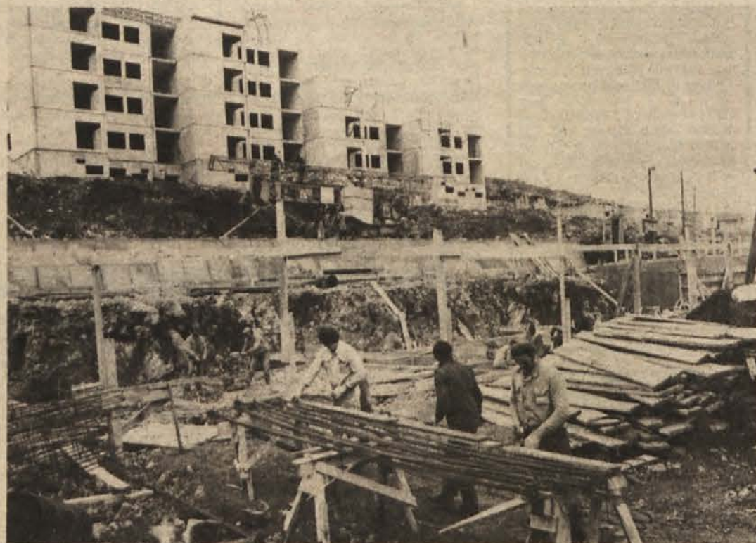
Gradbena dela do prve plošče v naselju Škurjinska Draga na Reki.
