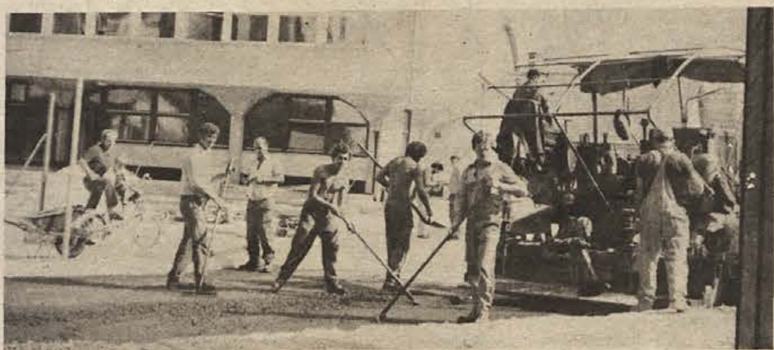
V teh jesenskih dneh je Kočevje spet dobilo nekaj asfaltnih površin, prav tako nekatera naselja v drugih krajevskih skupnostih. Na fotografiji: asfaltiranje nove ceste, ki povezuje Kidričevo ulico in Tomsčovo cesto v Kočevju. (Foto: J. Primc)
