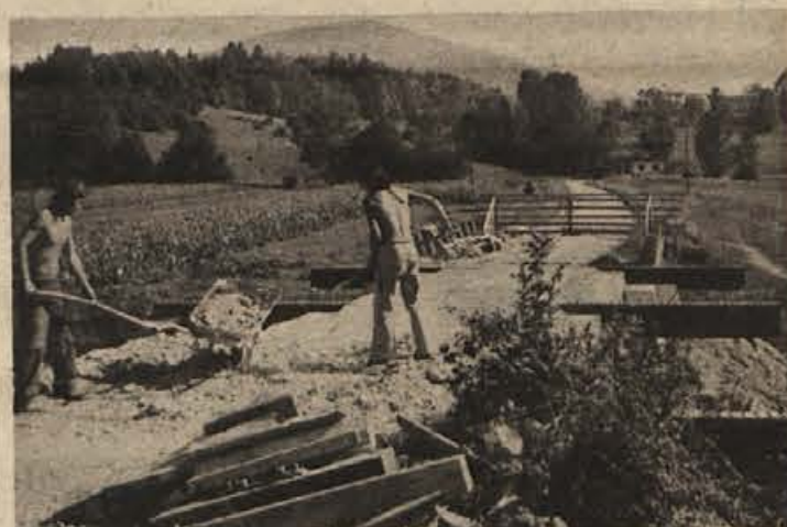
Rakitniški most, o katerem smo že pogosto pisali, da propada, zdaj obnavljajo. Kmalu bo spet sposoben za varen promet. (Foto: Jože Primc)
