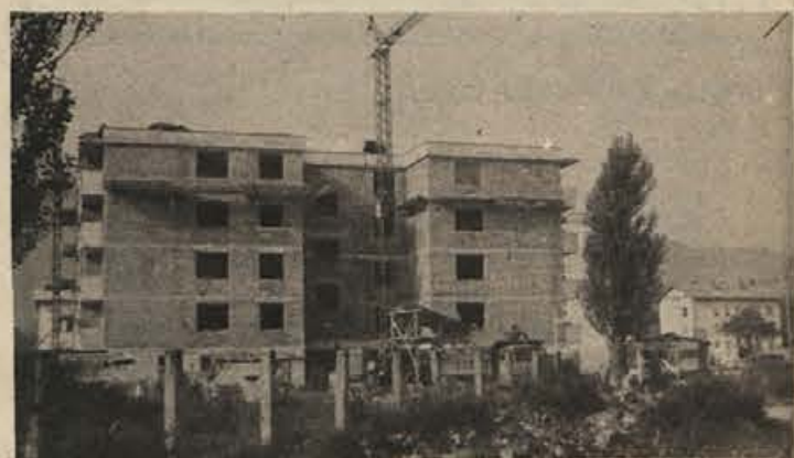
Gradnja stanovanjskega bloka A 2 v Ribnici lepo napreduje. Gradi ga SGP Zidar Kočevje. Blok bo končan že do konca tega leta. V njem bo 27 stanovanj, 10 izmed teh je odkupil solidarnostni sklad. (Foto: Primc)
