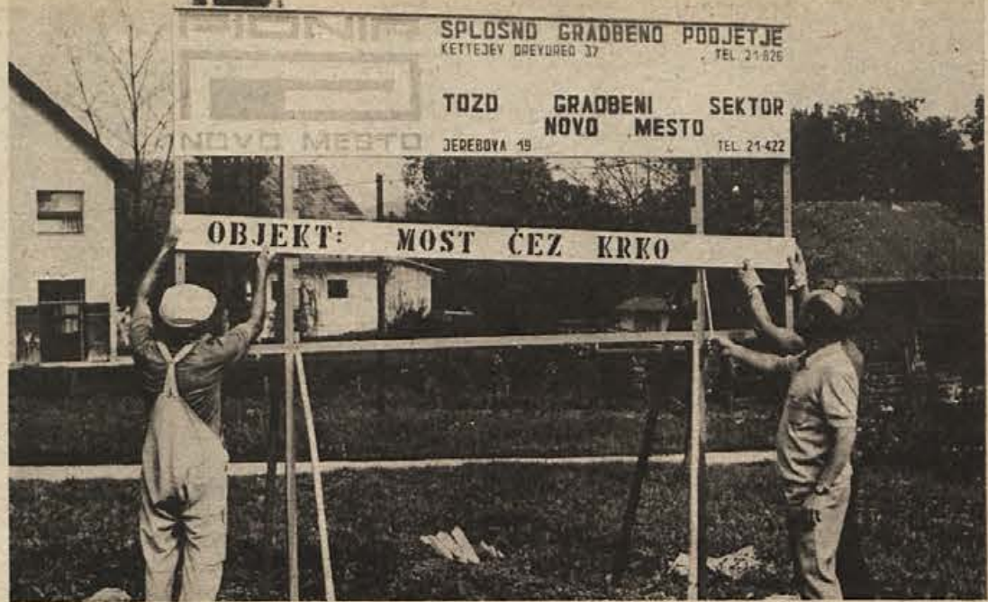
Po dolgotrajnih obljubah – sedaj prva lopata. Delavci SGP PIONIR so v ponedeljek začeli pripravljati gradbišče bodočega mostu čez Krko. Most bo povezan s cesto, ki bo šla med Gorenčevo hišo in topljarjem pri veterinarski postaji. (Foto: M. Vesel)
