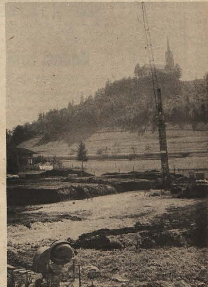
Prvič v zgodovini Mokronoga se je v kraju pojavil pravi žerjav. Postavilo ga je Splošno gradbeno podjetje Grosuplje na gradbišču nove šole. Dela doslej lepo napredujejo. Minuli teden so bili opravljeni že vsi potrebni izkopi. Veliko gradbišče, kar so vsa leta tako pogrešali v Mokronogu, slednjic le vzbuja upanje, da se tudi v tem delu občine dejansko nekaj premika. Na sliki: na videz je gradbeni žerjav „višji“ od cerkve na Žalostni gori! (Foto: Železnik)
