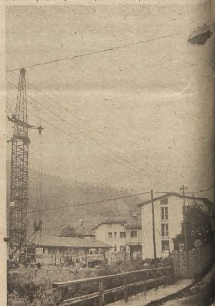
V Sodražici so avgusta začeli zidati poslovno-stanovanjsko zgradbo, v kateri bo 15 stanovanj in trgovina. Veljala bo okoli 10 milijonov dinarjev. (Foto: J. Primc)
