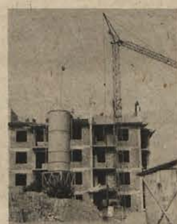
Za vrtcem gradi TGP 41-stanovanjski blok, ki bo največji v Metliki in bo imel tudi dvigalo. Čeprav so se nekateri bali, da je blok prevelik, so v njem že vsa stanovanja prodana. Nekaj bo tudi solidarnostnih stanovanj. Kvadratni meter površine stane 7060 din s komunalno ureditvijo, kar je za današnje razmere nizka cena. (Foto: R. Bačer)
