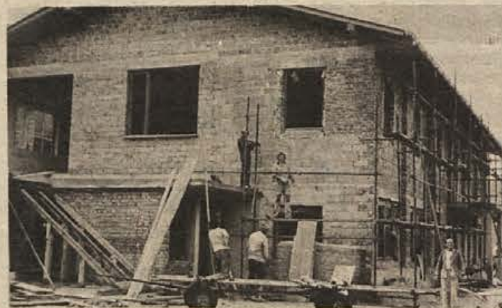
V kratkem bo končano preurejanje stare žage in pisarniških prostorov TOZD INLES v Sodražici. Dela opravlja Gradisce iz Cerknice. (Foto: J. Primc)
