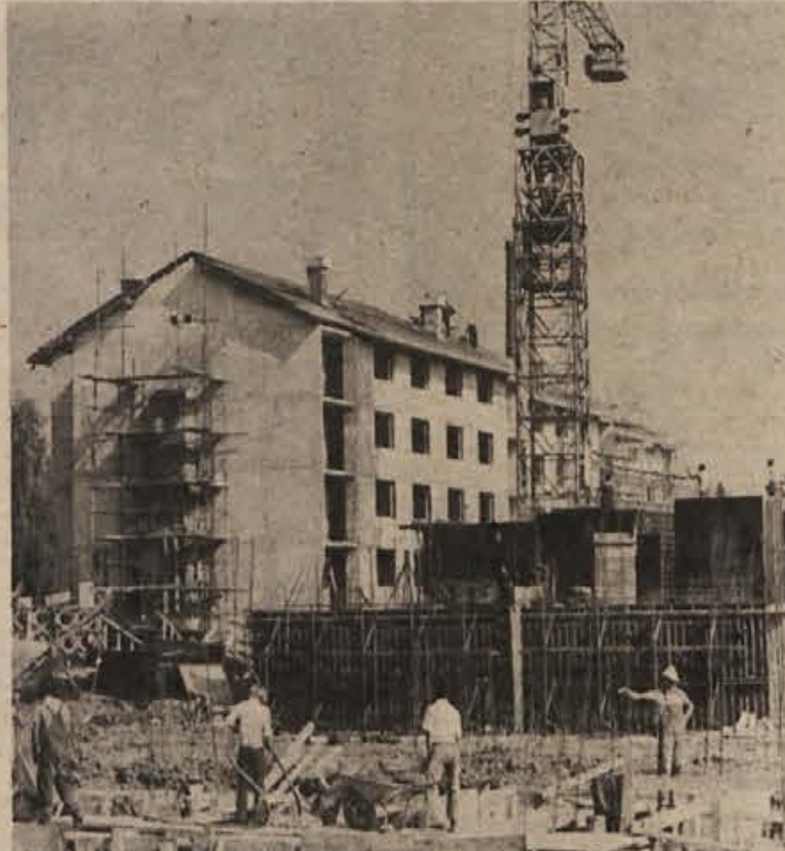
V Tesarski ulici v Kočevju gradi SGP Zidar 101 stanovanje v 6 blokih. Trije bloki bodo predvidoma vseljeni že do novega leta. (Foto: France Brus)
