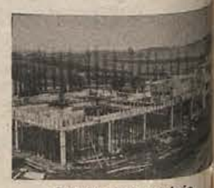
Objekt med gradnjo
