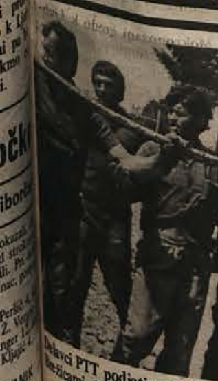
Delavci PTT podjetja v Stari vasi odvijajo telefonski kabel, s katerim obnavljajo zvezo med Krškim in Brežicami. (Foto: Jožica Teppey)
