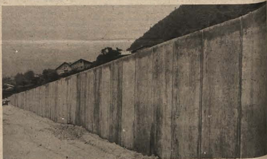
Oporni zid, zgrajen s pomočjo opažno-betonskih plošč, je bil hitro in varno nared. Tudi cenejši je od klasičnega načina gradnje.
