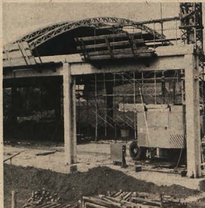
V nastajajoči industrijski coni na Cikavi pri Novem mestu gradi svoja skladišča tudi gradbeno podjetje Novograd. Po predračunu bo prvi objekt, ki ga zdaj gradijo (na fotografiji), vreden 1,8 milijona dinarjev. (Foto: Splichal)
