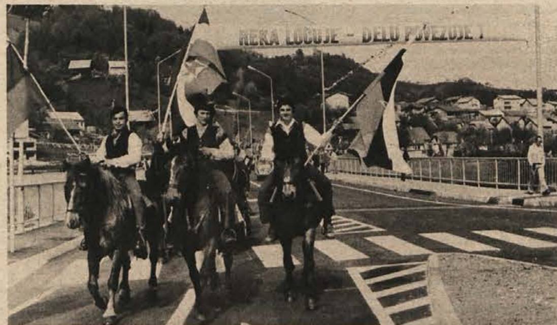
Graditelji mostu so na slavalok ponosno zapisali: „Reka ločuje - delo povezuje!“ Novi most bo opravljal svoje tudi pri „zlivanju“ Sevnice in Boštanja, še posebno ko bodo zgrajeni nekateri objekti na boštanjski strani: motel, črpalka in drugo. (Foto: Železnik)
