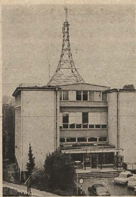
Poslopje PTT podjetja v Novem mestu je višje za 17 metrov: nanj so montirali antenski stolp za UKV telefonske zveze (radio relejne zveze) za medkrajevne telefonske pogovore z Belo krajino. Stolp je izdelalo Ključavničarsko podjetje iz Ljubljane; skupna vrednost investicije znaša 3.450.000 din. (Foto: Sandi Mikulan)
