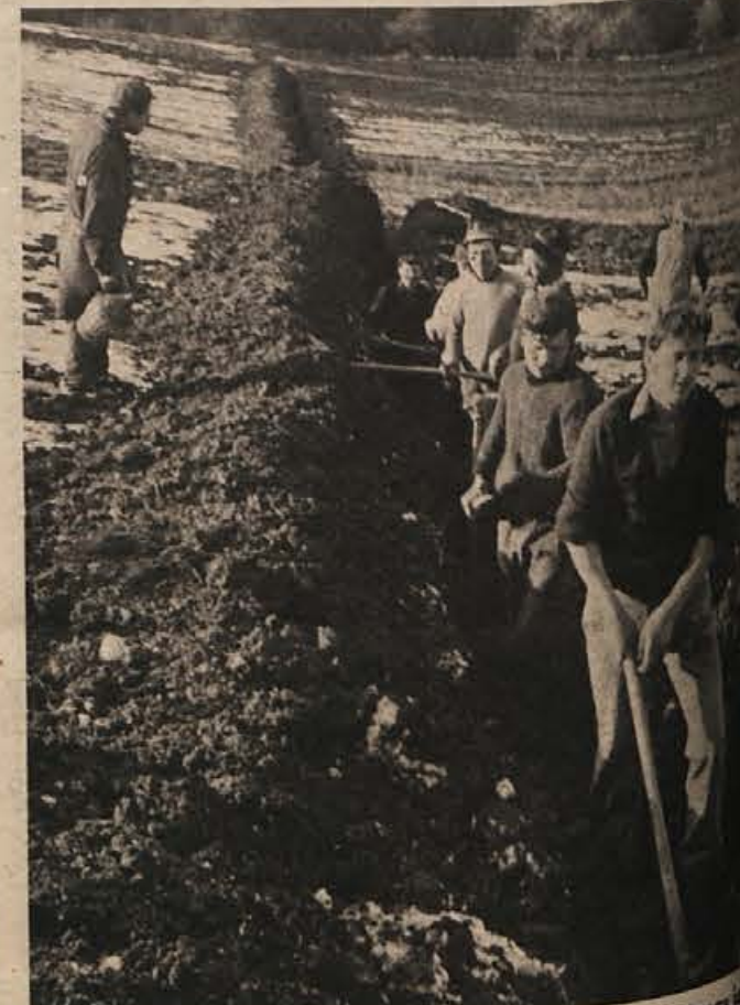
Kodričevi iz Brezja morajo skopati 190 metrov vodovodnega sistema v strmino. Na pomoč so poklicali delavce iz Gradca in s hrvaške strani. Tule na pomoč ni skal, niže doli pa se začneja 800 metrov skalnatega sveta, kjer brez minerjev ne bodo nič opravili. (Foto: Jožica Teppey)
