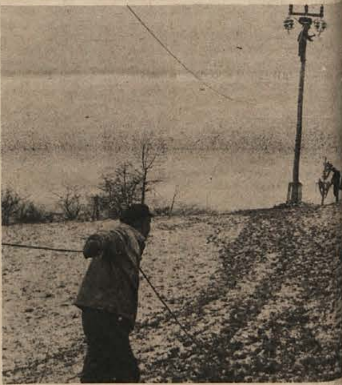
Konec februarja so delavci Elektra Novo mesto, gradbena skupnost iz Črnomlja, okoli Metlike podaljšali električno zanko. V primeru, da bi na starem daljnovodu zmanjkalo elektrike, bi s pomočjo nove zanke, ki jo bodo kasneje še podaljšali, Metličanom svetilke vseeno gorele.
