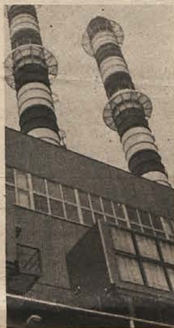
Dimniki elektrarne v Brestanici
